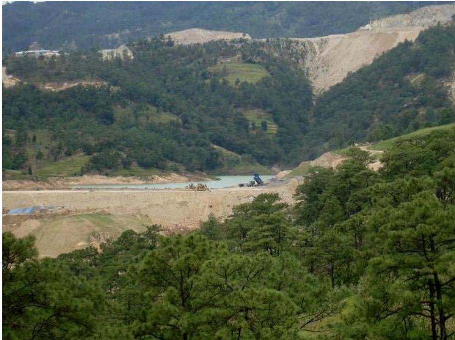
En esta foto se ve el lago formado por la mina Marlin (“dique de colas”), que se encuentra en su parte baja. El lago contiene aguas residuales, que ya no sirven a la empresa. Se puede observar que el nivel del lago casi alcanza el nivel de la barrera de soporte.
